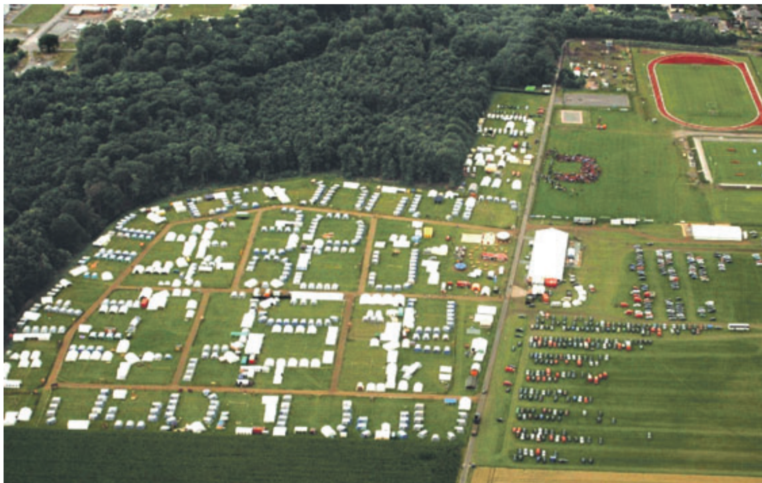
Beeindruckend: Das Zeltlager auf dem elf Hektar großen Gelände bei den Sportstätten in Rehden ist wie eine kleine Stadt aufgebaut. Selbst Elektro-, Telefon- und Abwasserleitungen wurden verlegt, damit es den 1854 Teilnehmern an nichts fehlt.
